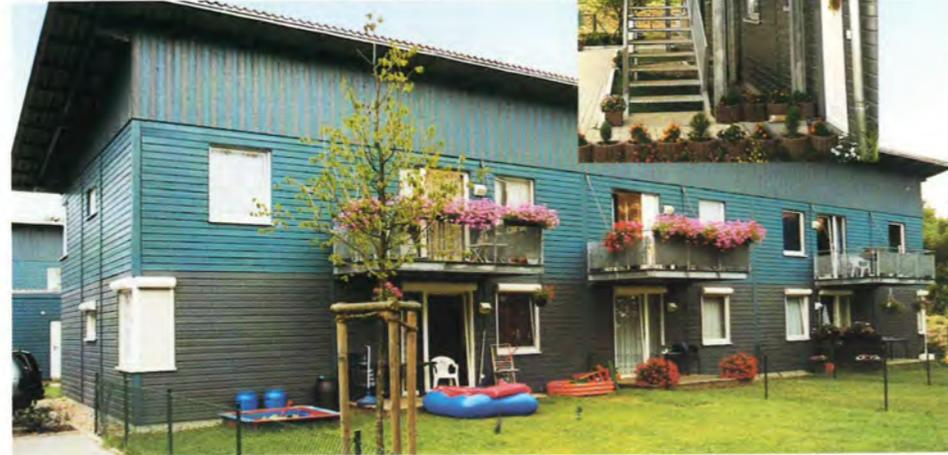
Vorbildlich: In der Efeustraße in Duisburg-Wanheim entstanden Ende der 1990er Jahre als Modellprojekt insgesamt 68 Mietwohnungen in Holz- und Massivbauweise. Das Nutzwasser wurde durch Solarenergie erwärmt, Wintergärten dienten als Wärmespeicher, Strom wurde durch Photovoltaik-Anlagen erzeugt.
